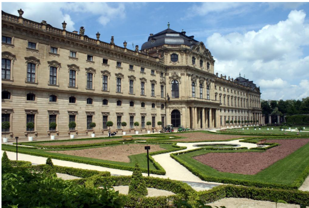
Residenz vista dai giardini
